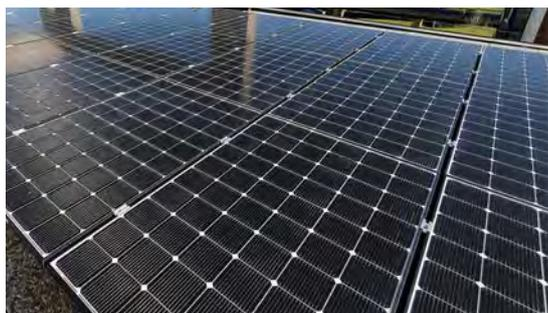
I pannelli saranno fissati ad una idonea struttura in acciaio zincato di sostegno. L'impianto sarà destinato a produrre energia elettrica ed alimentare le pompe di calore sia per il riscaldamento, il raffrescamento, che per la produzione di acqua calda. Questo tipo di impianto consentirà un notevole risparmio sulle spese elettriche (individuali o condominiali)
