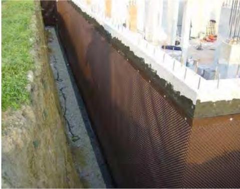
Inoltre, per garantire un corretto drenaggio delle acque meteoriche, sopra il massetto di protezione verrà applicato uno strato di scorrimento costituito da fogli di geo-composito drenante o ghiaietto. L'impermeabilizzazione dei balconi verrà eseguita mediante la posa di una membrana impermeabile successivamente protetta da un massetto in calcestruzzo ulteriormente impermeabilizzato mediante la stesura di malta cementizia tipo "Mapelastic".
