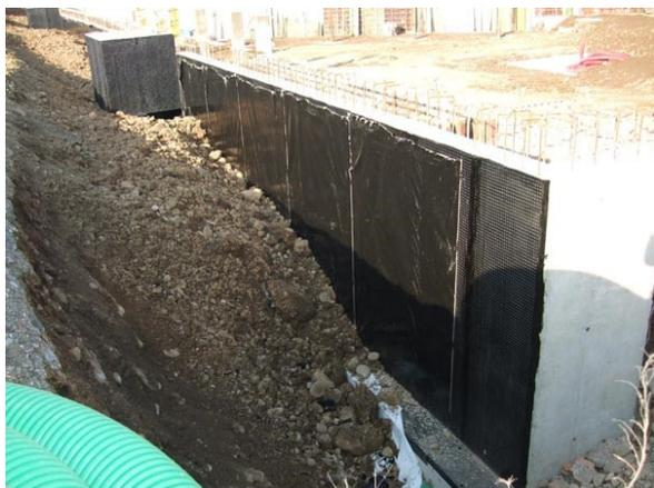
Inoltre, per garantire un corretto drenaggio delle acque meteoriche, sopra il massetto di protezione verrà applicato uno strato di scorrimento costituito da fogli di geo-composito drenante o ghiaietto.
